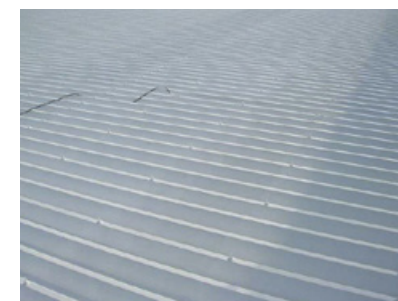
K社・工場(折板屋根)
